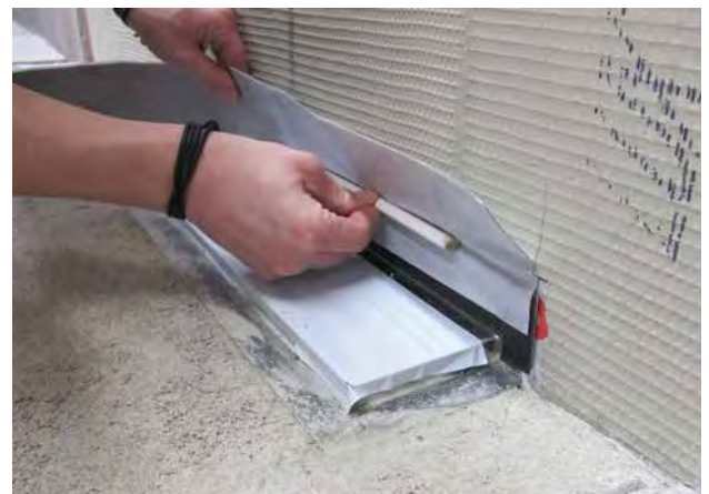
Verkleben des Sopro FlexDichtBandes mit Schlaufe als Übergang zwischen dem Metallflansch der Rinne und den angrenzenden Baustoffen.
