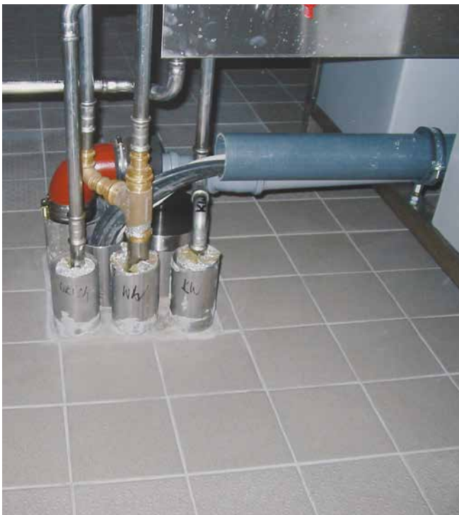
Hüllrohre (Sonderanfertigung) zur Durchführung von Versorgungsleitungen
